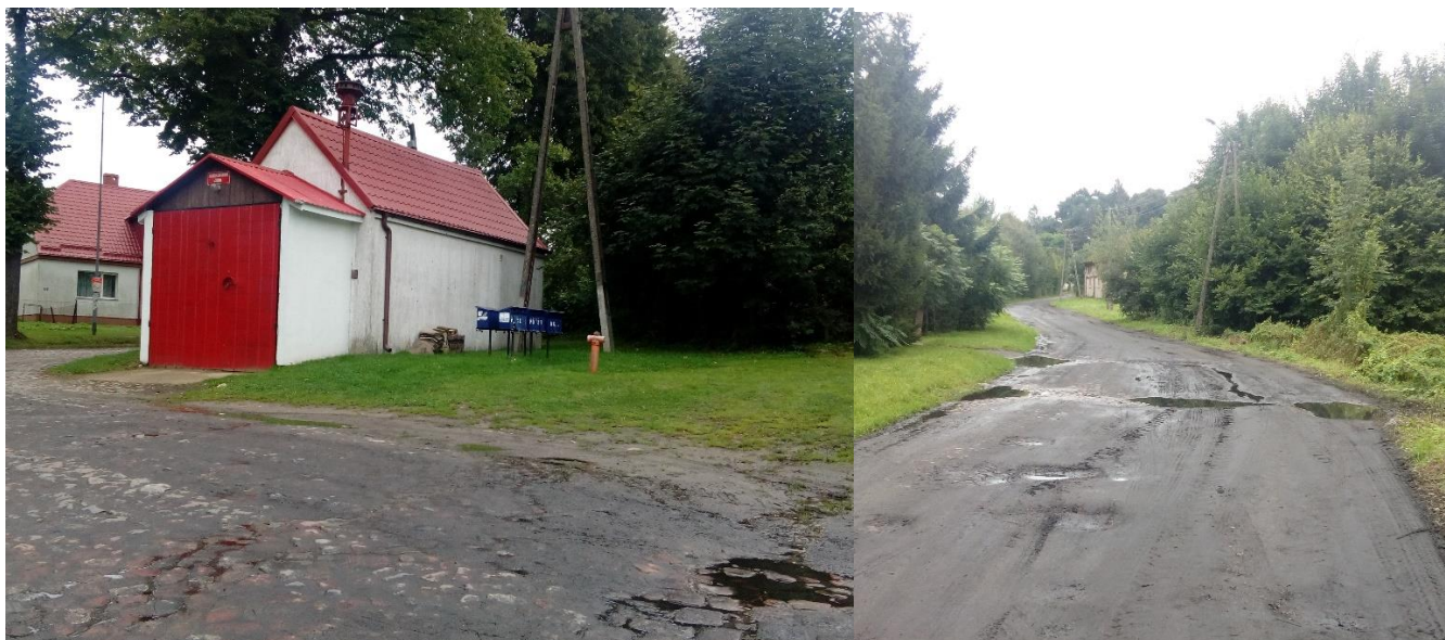
Istniejąca remiza strażacka w Starninie oraz droga gminna prowadząca z centrum miejscowości do miejsca realizacji niniejszego projektu rewitalizacyjnego. Fot. A. Zalewska, 2017
